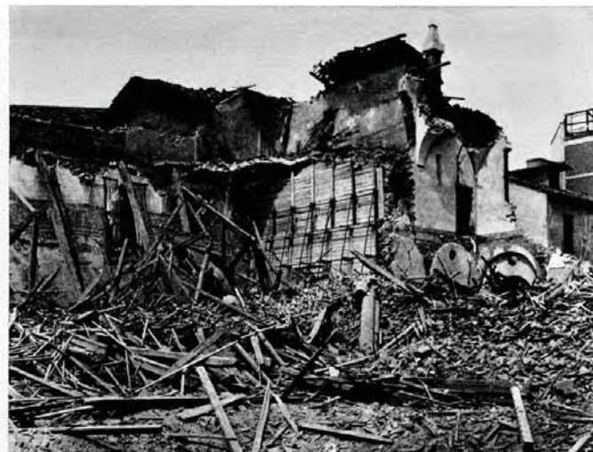
Nella notte tra il 15 e il 16 agosto 1943, nel corso di un'incursione aerea, una bomba di due tonnellate cadde nel chiostro del convento e ridusse il refettorio in queste condizioni. La grande composizione murale di Leonardo rimase miracolosamente intatta perché era stata preventivamente protetta da una pila di sacchetti di sabbia e da un rivestimento di assi (al centro, nella foto). Poi, ricoperto da un semplice telone, il capolavoro rimase abbandonato in quelle condizioni per oltre un anno.
